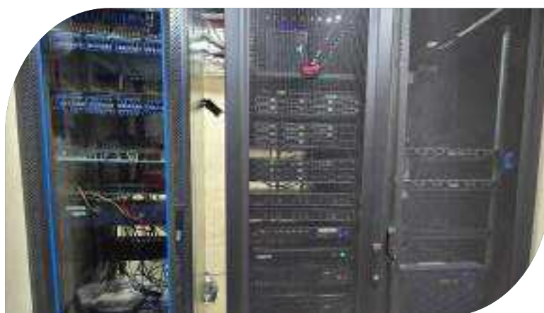
Ordenamiento, reorganización física y limpieza del Centro de Datos.
